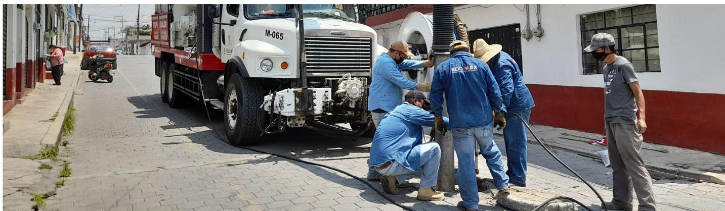
Para evitar inundaciones, se realizó el desazolve a toda la red general de drenaje de los diferentes barrios de la cabecera municipal. Y con la ayuda de equipo tipo vactor se realizaron 25 desazolves en la línea general de agua potable. Además, el equipo del organismo realizó más de 50 desazolves en las diferentes alcantarillas de captación de agua pluvial.
